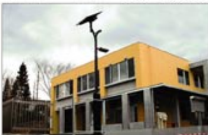
宮城県仙台市 荒巻コミュニティ・センター
